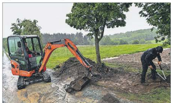
Ausschachten im starken Regen.
