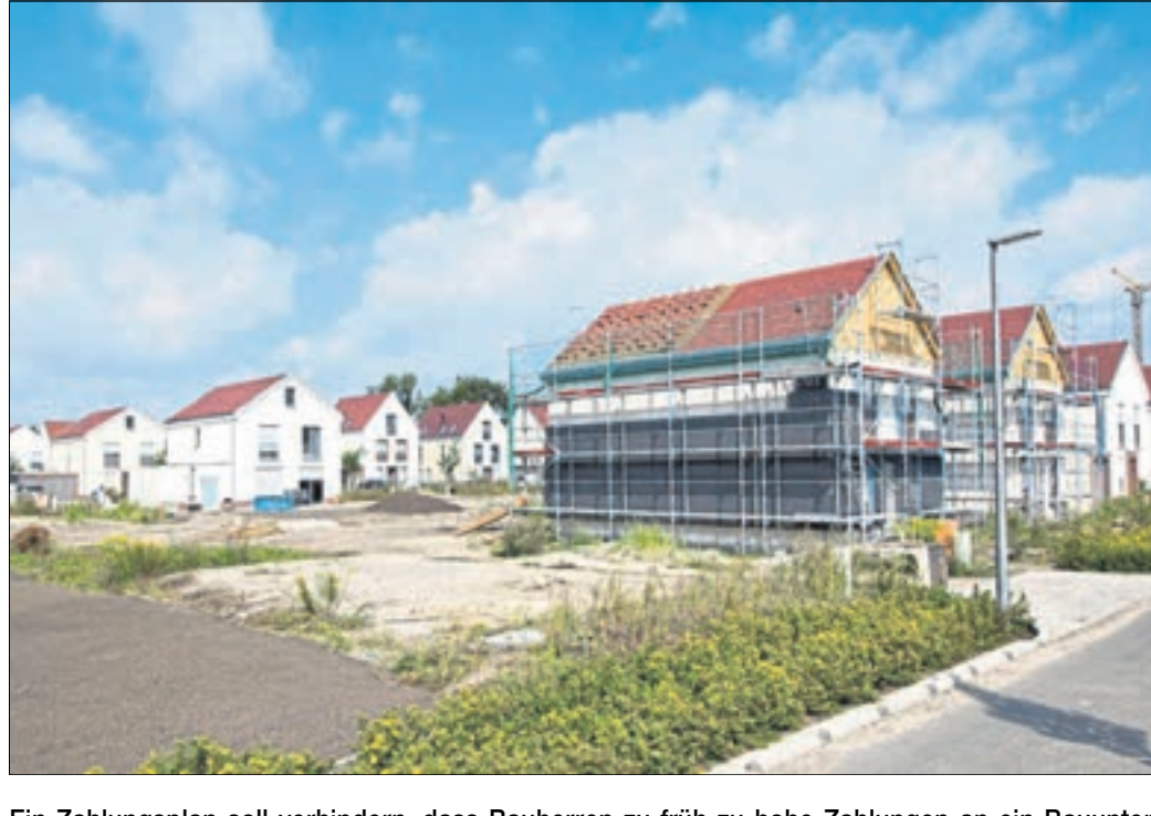
Ein Zahlungsplan soll verhindern, dass Bauherren zu früh zu hohe Zahlungen an ein Bauunternehmen leisten. Foto: Florian Schuh/dpa-mag
