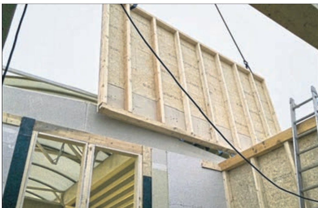
Mit Holzkonstruktionen und Gipsplatten lassen sich Bestandsbauten schnell und kosteneffizient aufstocken oder umbauen, ohne dass dabei statische Probleme entstehen. Foto: Siniat/bxn
