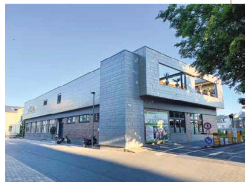
Nach anderthalb Jahren Umbauphase wurde Anfang Oktober 2021 eröffnet. Foto: Meine SportZEIT
